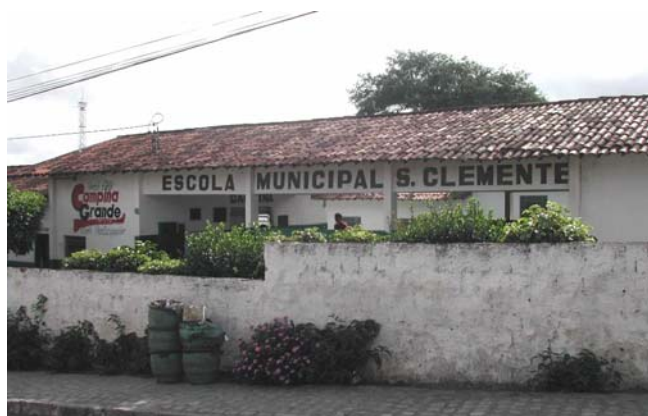
Figura 1. Fachada da Escola Municipal de Ensino Fundamental São Clemente, em São José da Mata.
