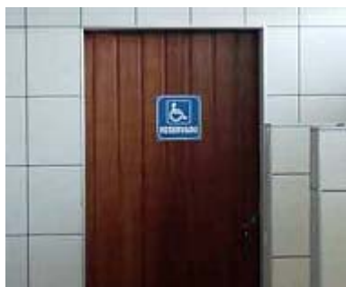
Exemplo de porta de sanitário adaptado
