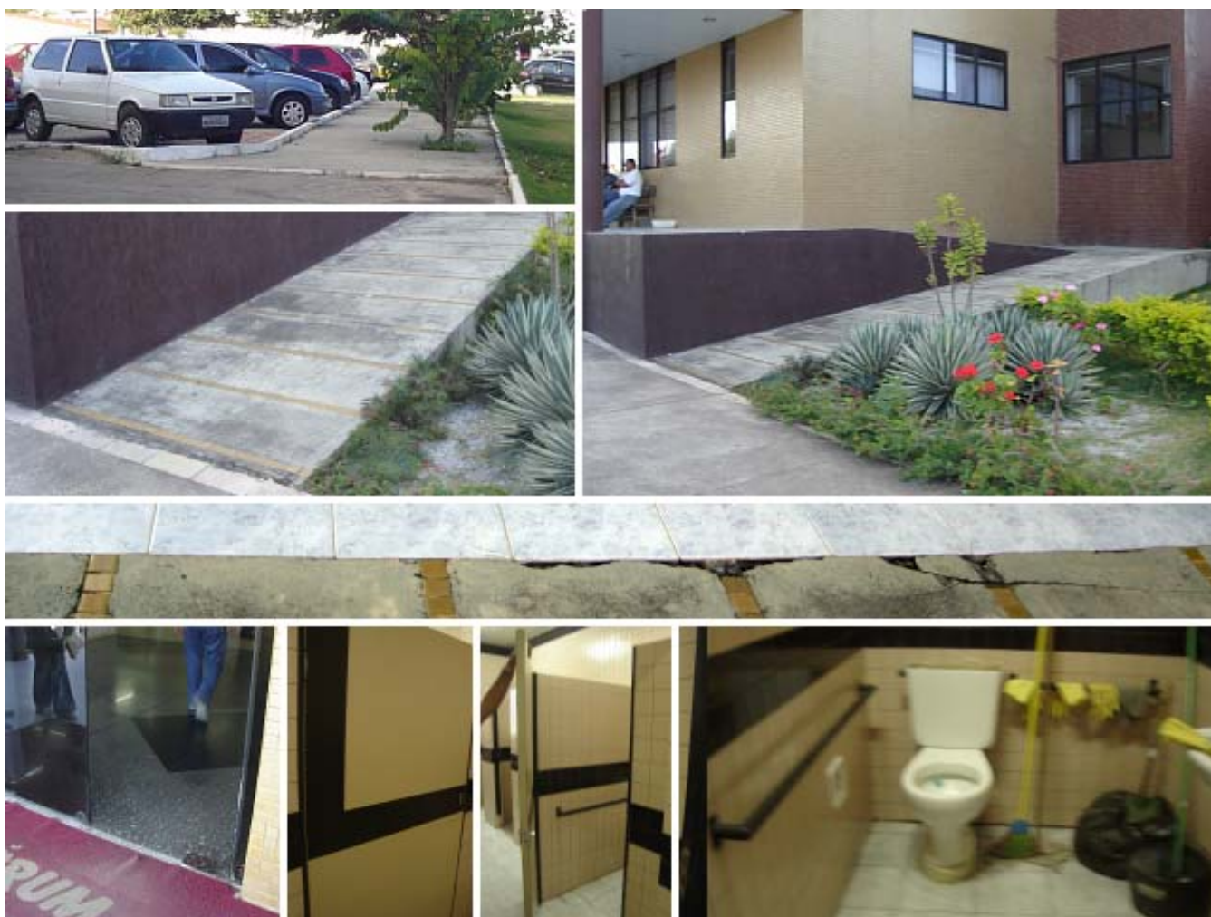
Não há estacionamento específico para P.N.E., além de algumas barreiras arquitetônicas e desníveis nas rotas de acesso; contudo, a edificação se mostra razoavelmente bem preparada para a questão da acessibilidade
