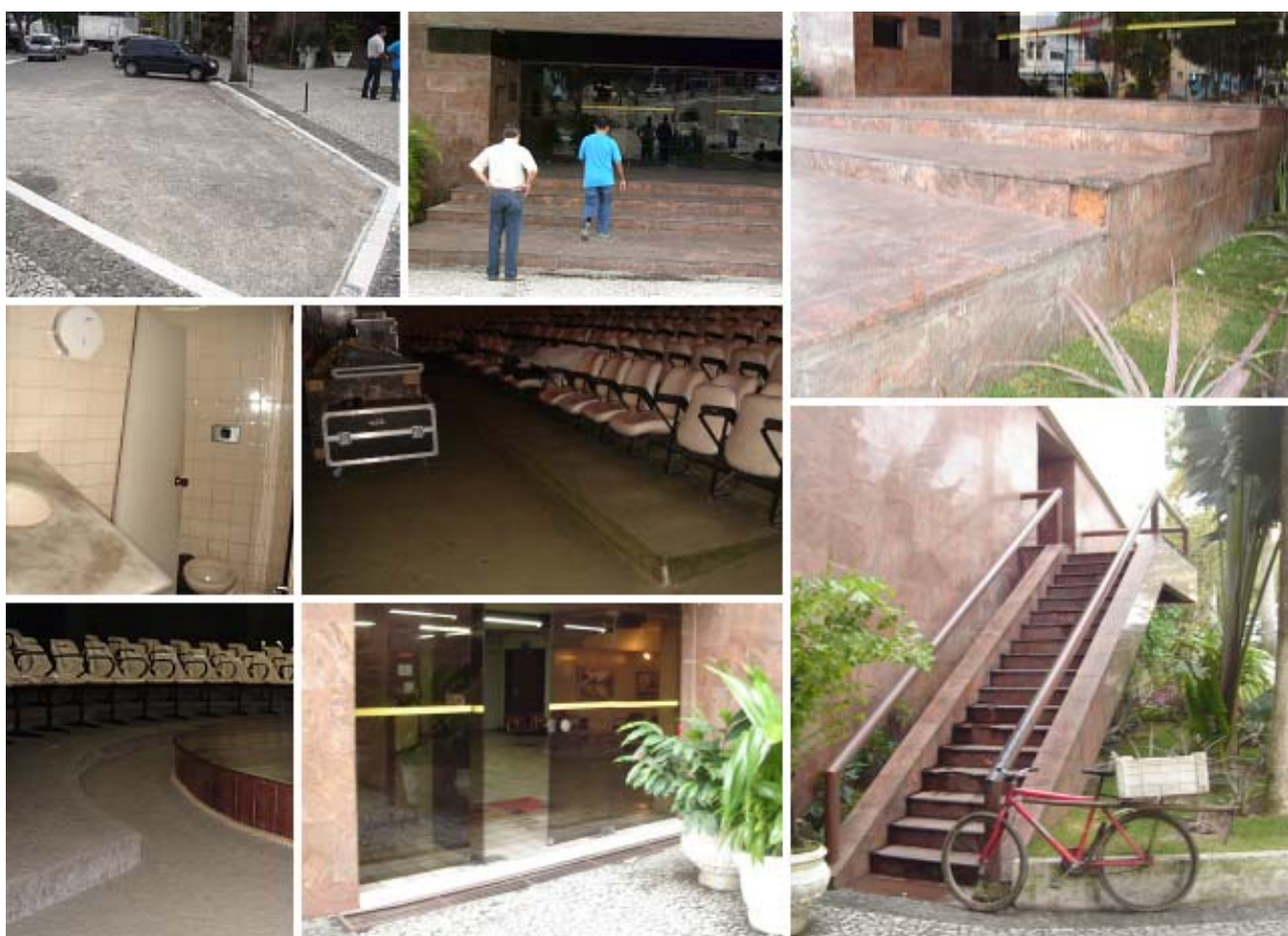
Apesar de existir acesso do estacionamento para calçada, não há vaga específica para P.N.E.; também não existem rotas de acesso, rampas, elevadores, banheiros adaptados ou outros itens direcionados a P.C.R.
